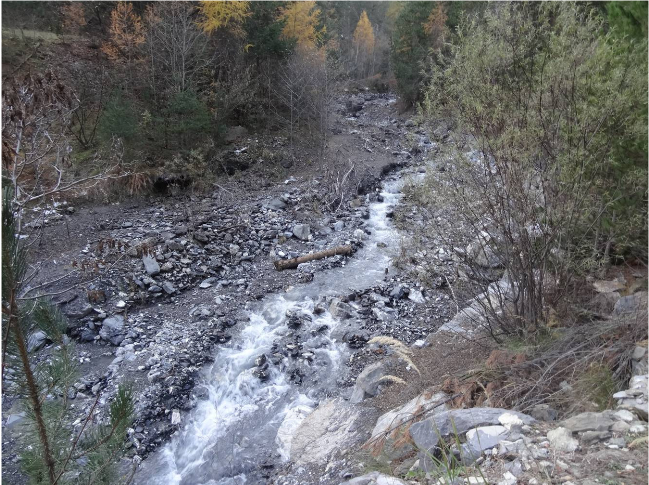
Photo 22 : Lit en amont du village.
