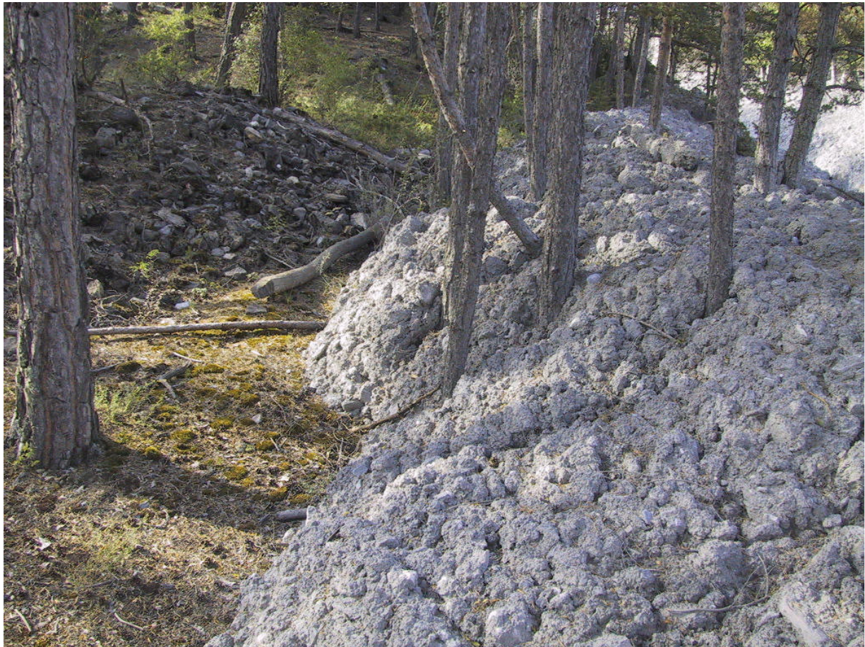
Photo 26 : Bourrelet latéral sur la crête de digue du torrent de Faucon.
