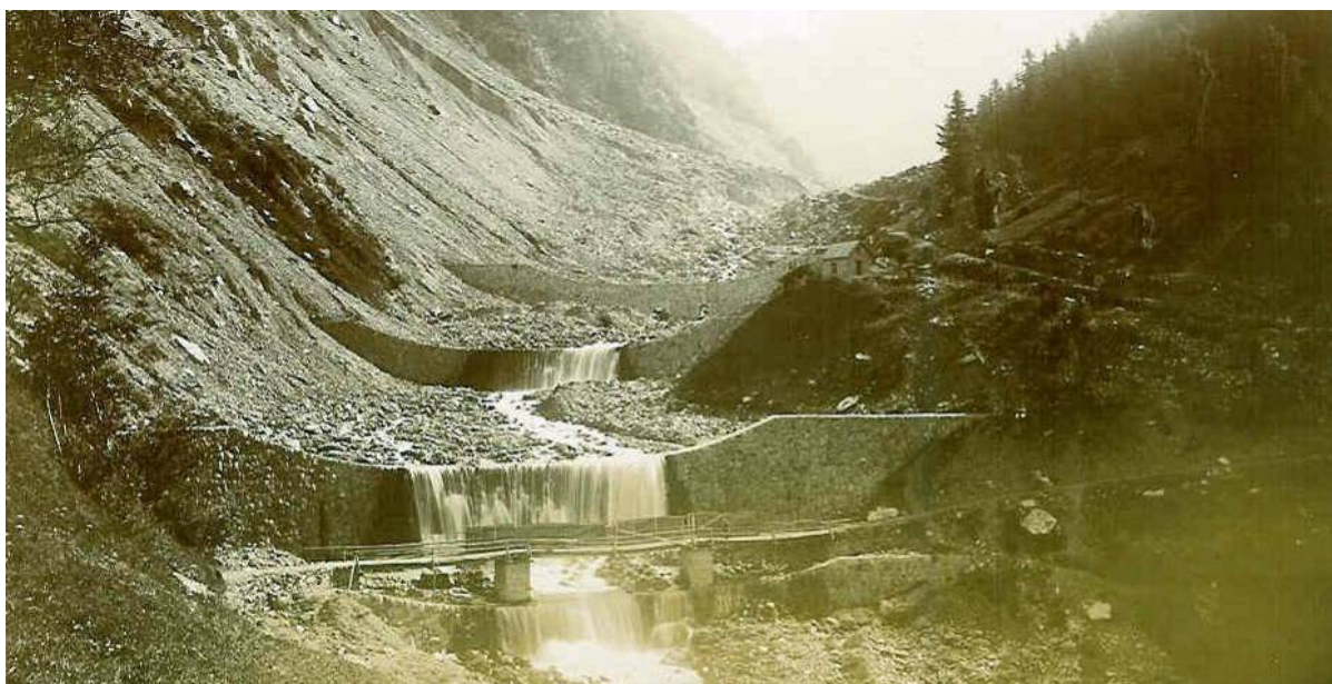
Figure 13 : Zone de reprise au pied de l'éboulement.
