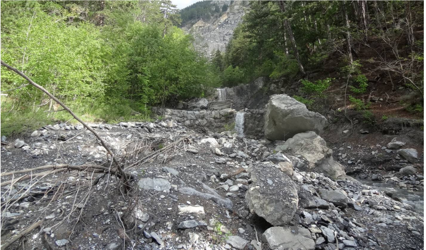
Photo 20 : Barrages de régulation du transport solide en aval de l'éboulement.
