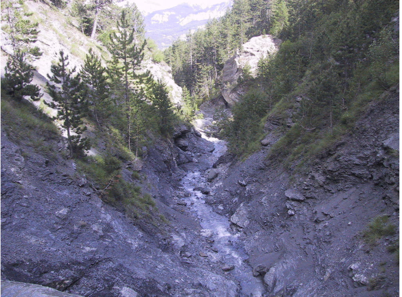
Photo 4 : Lit au droit de l'éboulement en 2004.
