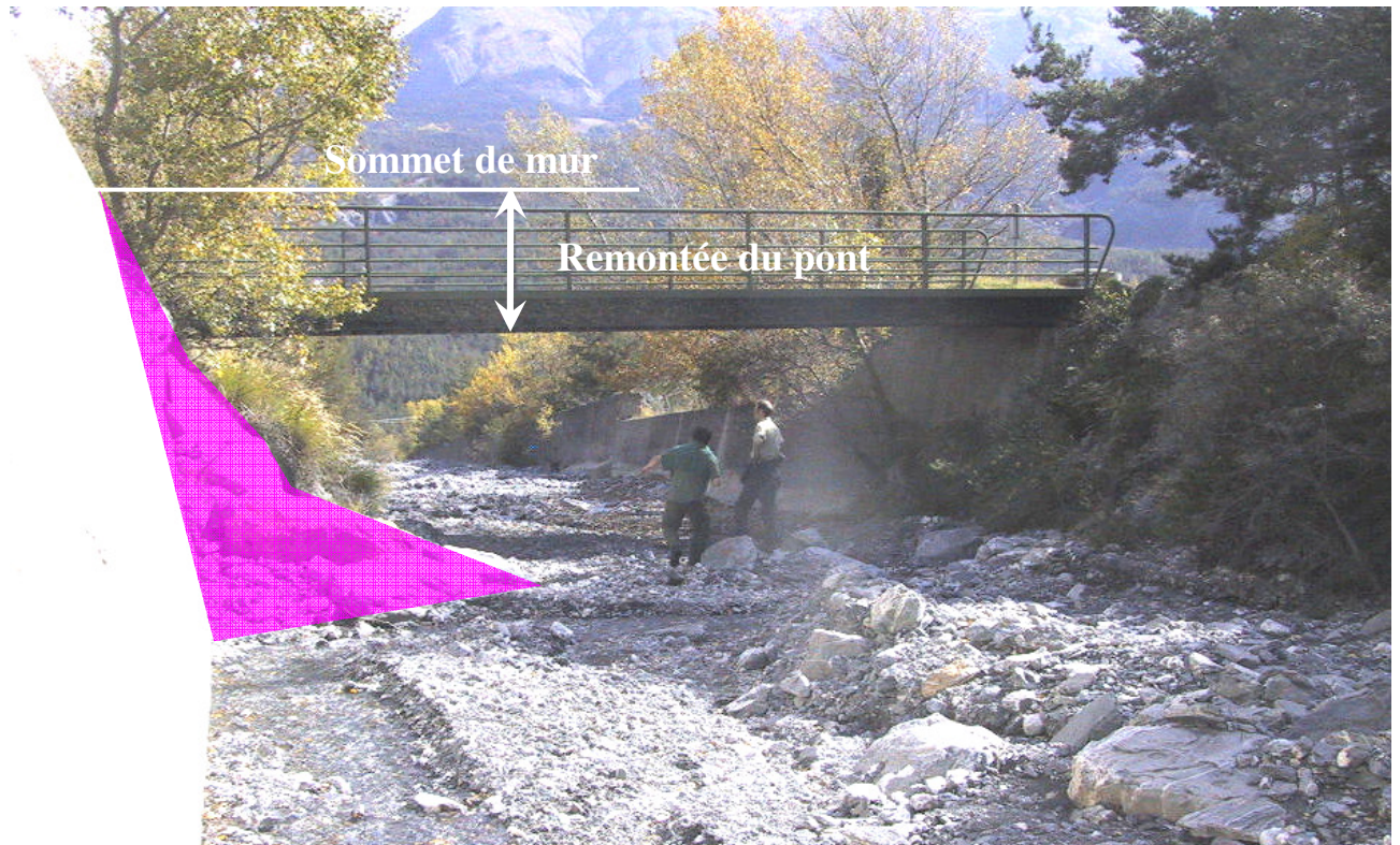
Figure 41 : Reconstruction de la culée rive gauche du pont de Briançon.
